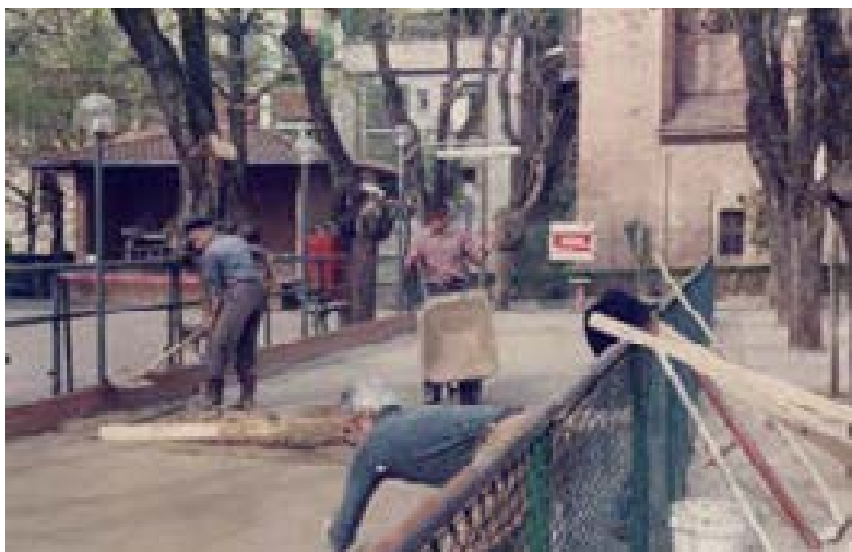
Volontari al lavoro nello spazio di Via Ponte Muratori, per realizzare i campi da bocce.
