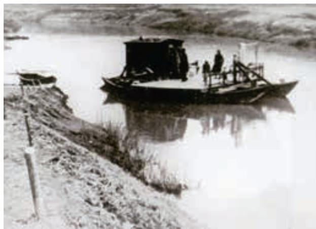
*Passo con barca (sul Secchia, ma simili erano quelli sul Panaro). Osservando attentamente la foto, si vede la fune-guida, tesa fra le opposte sponde, utilizzata per evitare che nell'attraversamento del fiume la corrente trascinasse la barca oltre il punto di attracco sull'altra riva.*
